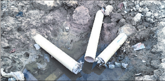
कलायत। भवन में कच्ची मिट्टी में दबाई जा रही सीवरेज लाइन फोटो : हरिभूमि
